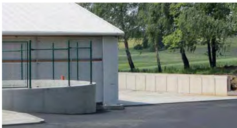
Nově vybudovaná jímka a hnojná koncovka
