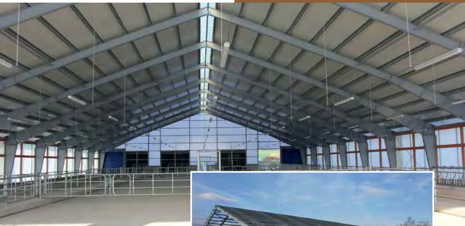
Pohled do nové stáje s technologiemi hrazení
