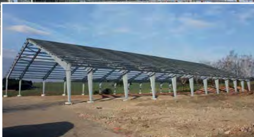
Ocelová konstrukce na místě původní stáje
